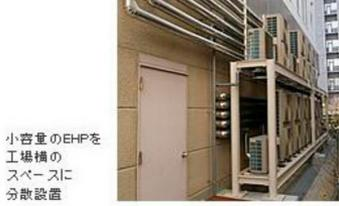
小容量のEHPを工場棟のスペースに分散設置
